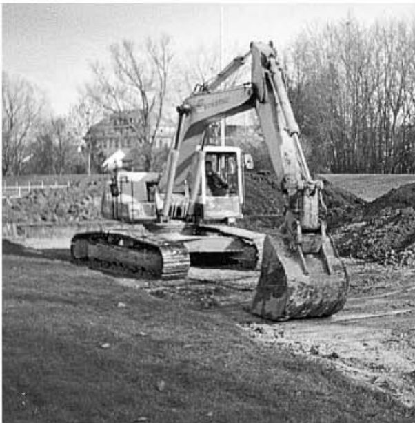
Baggerarbeiten für die Beach-Volleyball-Anlage.
